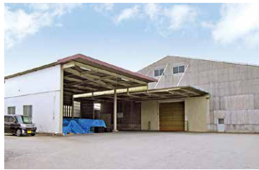
小泉倉庫 保管面積：1,083 坪 〒418-0022 富士宮市小泉202
