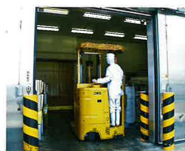
搬入より汚染を防ぐため、二重扉で仕切られています。
