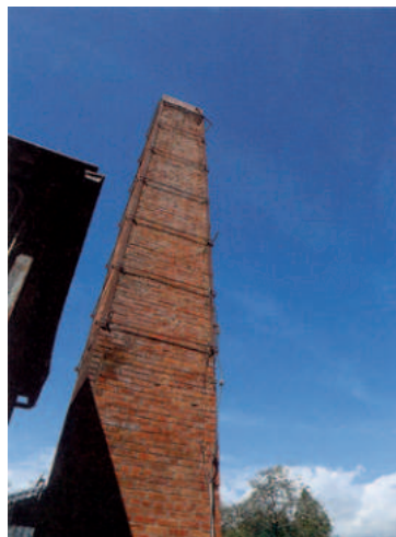
敷地内に残るレンガ造りの煙突。昭和60年頃まで蒸留の際の熱源に石炭を使っていました
