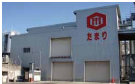
本社・第一工場
